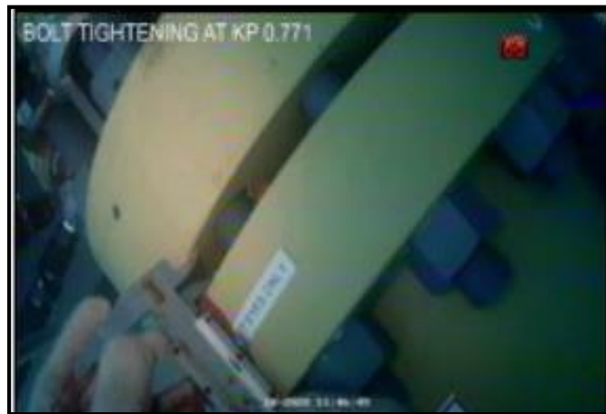
Hình 5. Quá trình căn chỉnh đoạn ống thứ nhất.
